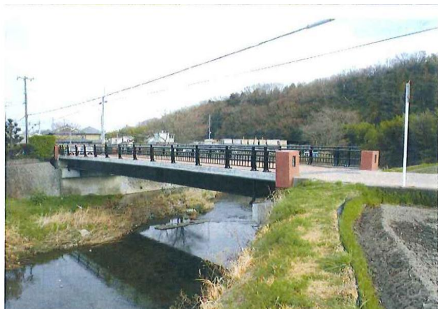
改修後の橋梁（山下橋）
