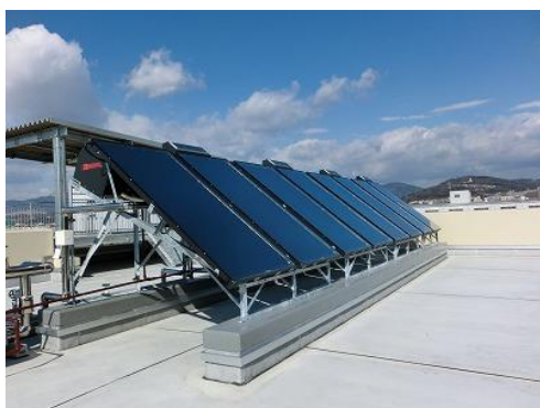
消防署西河原分署に設置した太陽熱温水器（写真左）とソーラーウインドライト（写真右）
